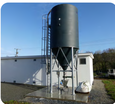
Un silo de stockage de calcaire a été installé à l'arrière du bâtiment.
